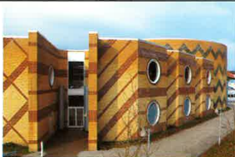
Bibliotheek en 'Trommen'-gebouw (Horsholm), 1988
